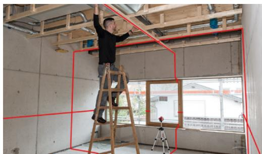
La croce sul pavimento e quella sul soffitto consentono la messa a piombo verticale precisa e quindi anche di riportare rapidamente e comodamente i punti di misurazione, ad esempio per il montaggio di punti luce e rivestimenti a soffitto.
